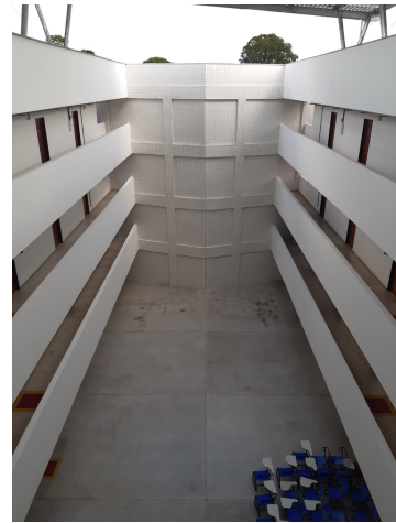
Fig. 2: Vista interna do prédio do CEAR/UFPB.
