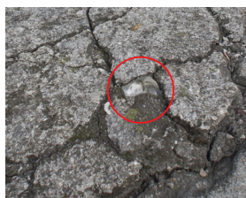
Fig. 11. Resultado da presença do pequeno pedaço de plástico transparente na superfície.
