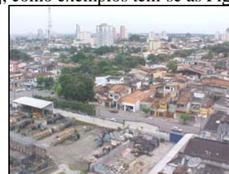
Fig.1 - Vista do transmissor de sinal da Rota 1 (Belém - Pará).
