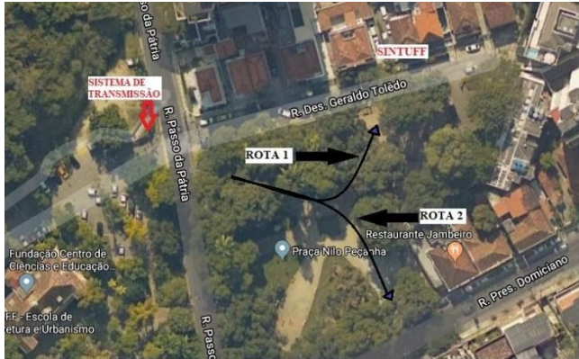
Fig. 1. Vista aérea da Pça. Nilo Peçanha destacando as rotas de medições [9].
