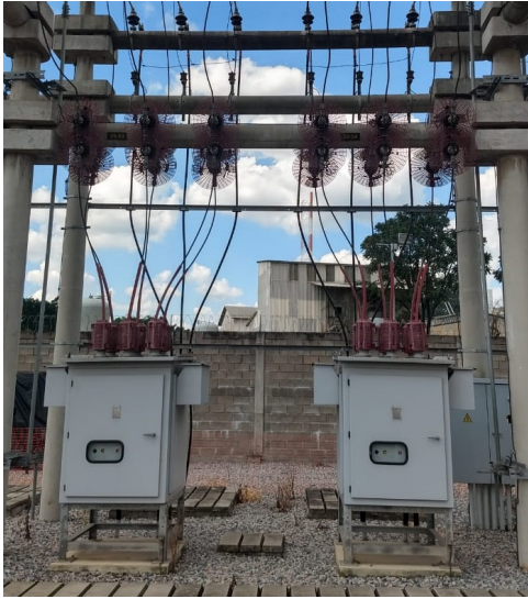
Fig. 1. Exemplo de dois alimentadores instalados em série.
